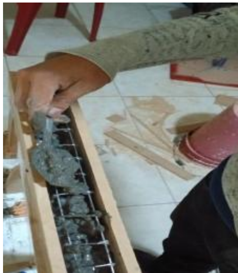
Figura 2. Vertido del hormigón en los encofrados.
