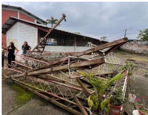
Imagen 2. Material en mal estado
