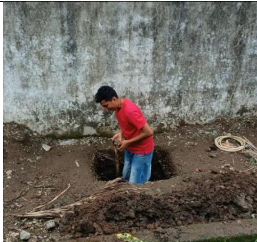
Imagen 6. Construcción de la cimentación
