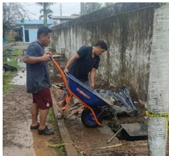
Imagen 7. Construcción de las placas Base
