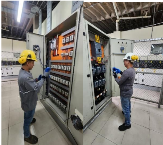
Figura 9. Captura de imágenes termográfica
