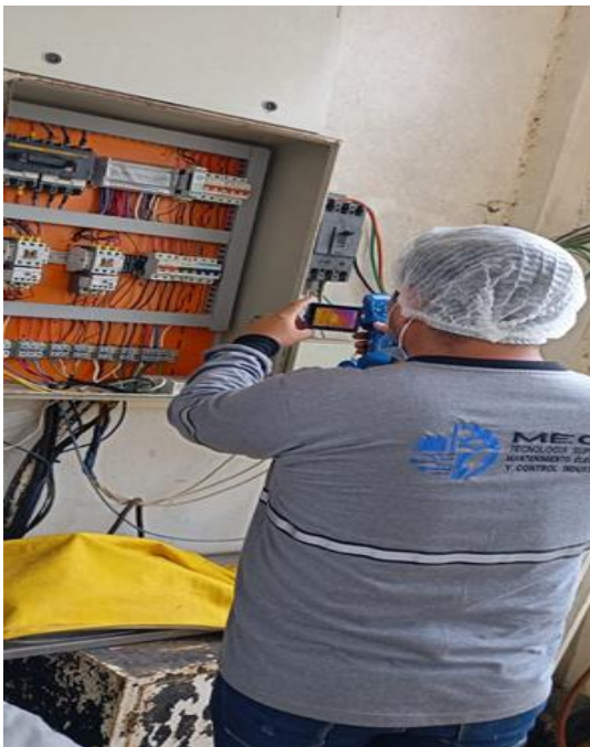
Figura 3. Captura de imágenes termográficas en la empresa Alimentos CADE.
