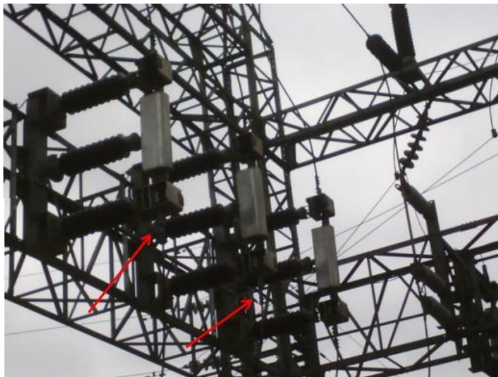
Figura 9: Cubículo interno CNEL EP Santo Domingo Av. Quito
