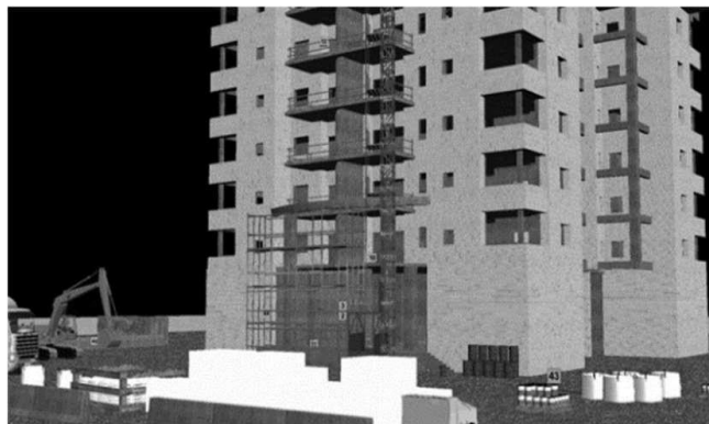
Fig.13. Vista parcial del edificio virtual en construcción, (Sacks, Perlman & Barak, 2013)
