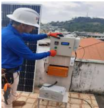
Figura N° 21 Encendido del controlador de temperatura.
