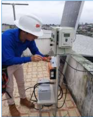
Figura N° 2 Instalación del controlador MPPT
