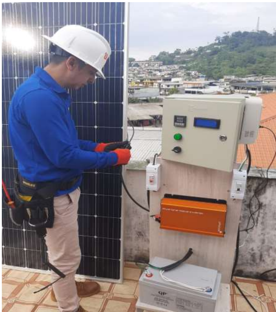
Figura N° 4. Instalación de panel solar monocristalino.
