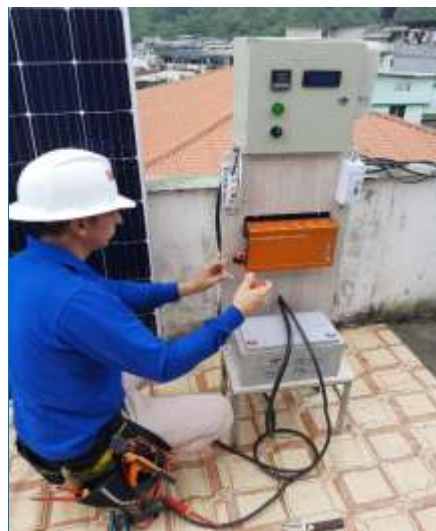
Figura N° 3 Instalación del inversor de voltaje a la batería.
