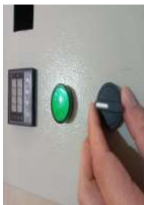
Figura N° 6. Instalación de los elementos de control.
