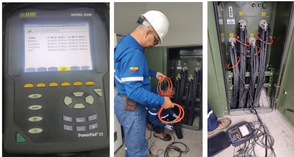
Se procede a instalar el analizador de carga en el cuarto de transformación por un lapso de 10 días. Una vez cumplido el tiempo, se instala el equipo en los bloques 1, 2, 3 y 4. Este equipo permite medir y realizar trabajos de diagnóstico y calidad de energía en redes de una, dos o tres fases. Se proporcionan cinco entradas de voltaje y cuatro entradas de corriente.
