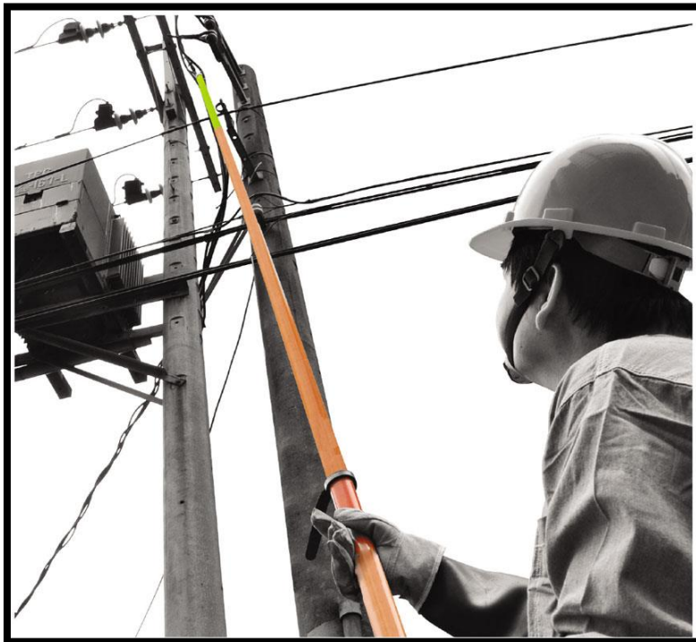
Figura N° 2: Uso de la pértiga telescópica
