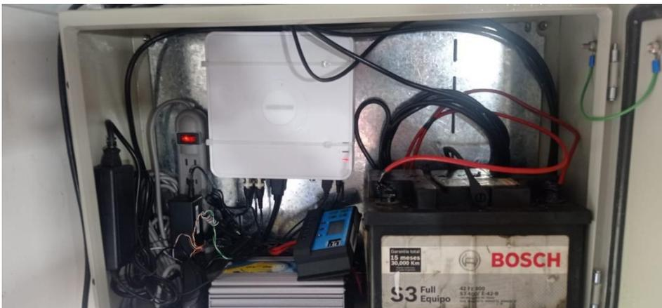
Figura 9. DVR ubicado en la caja metálica
