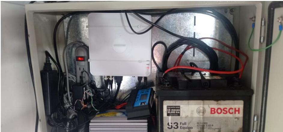
Figura 4. DVR ubicado en la caja metálica
